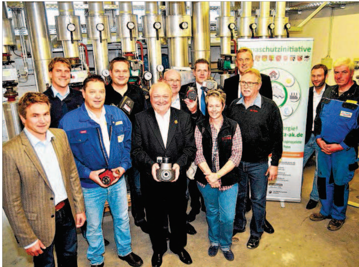
Fototermin im Heizungskeller: Gemeinsam mit den Projektpartnern stellten Landrat Michael Lieber und seine Mitarbeiter Lars Kober und Stefan Glässner gestern das Klimaschutz-Projekt „Die Alte muss raus“ vor.
